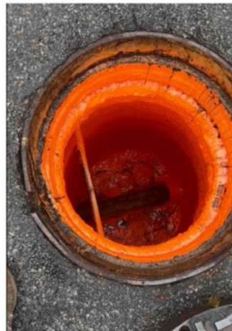
Figure 1. OBIC Composite Polyurea Lining System
